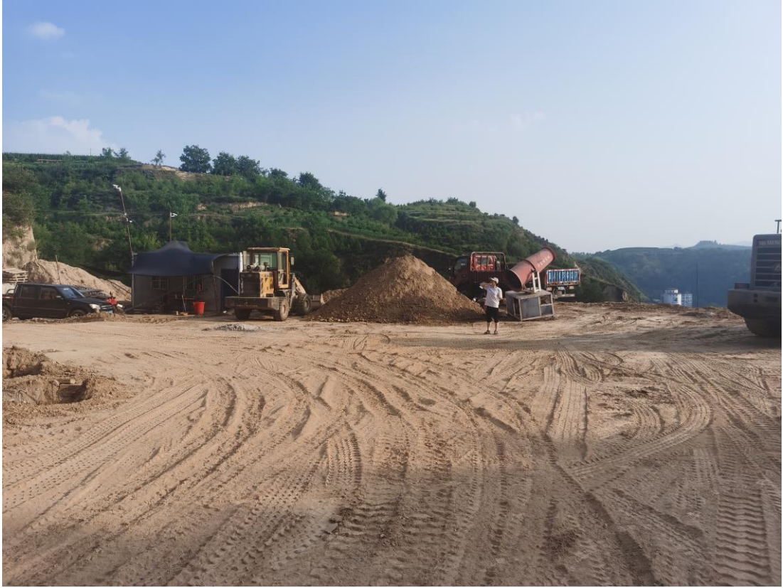
项目位置（已经完成场地平整）
